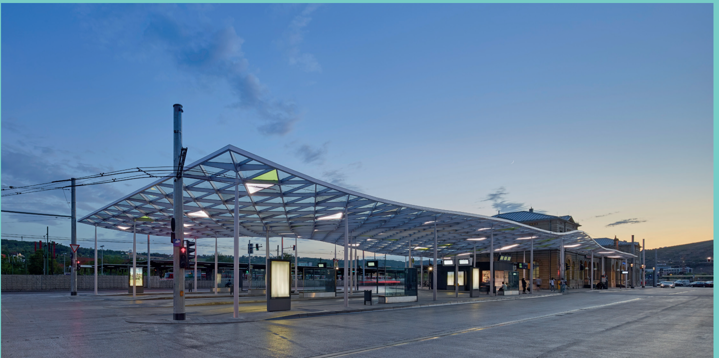
Überdachung Busanlage in Esslingen am Neckar – © Foto: Zooey Braun / Architektur: Werner Sobek
