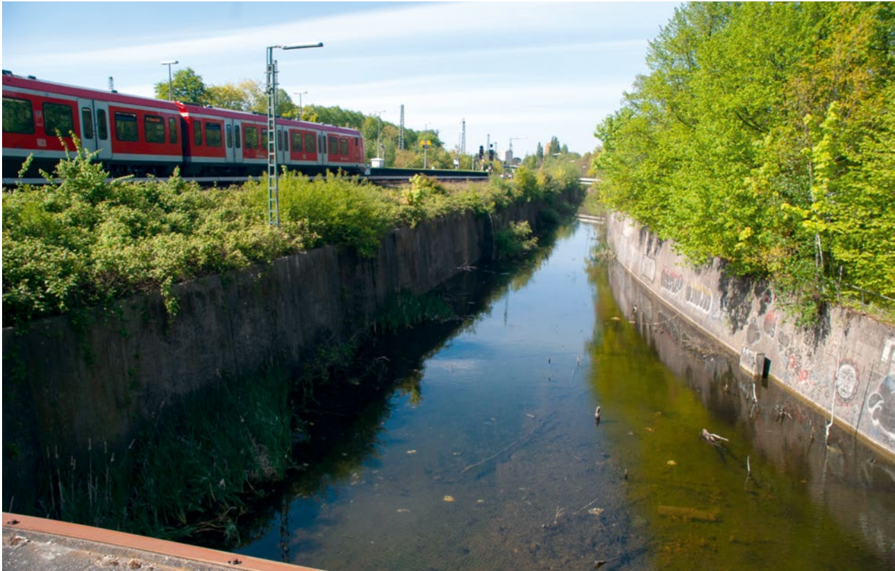
Die S-Bahn Haltestelle Diebsteich vor Beginn der Bauarbeiten
