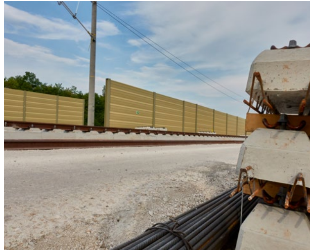
Neubaustrecke Wendlingen – Ulm
