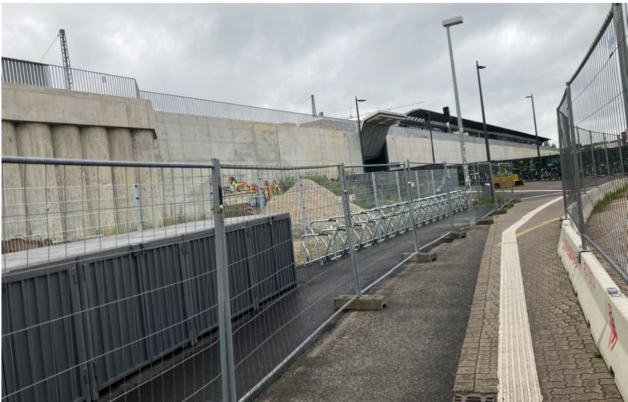
Die neue S-Bahn Haltestelle Diebsteich zeigt das verschwundene Grün deutlich
