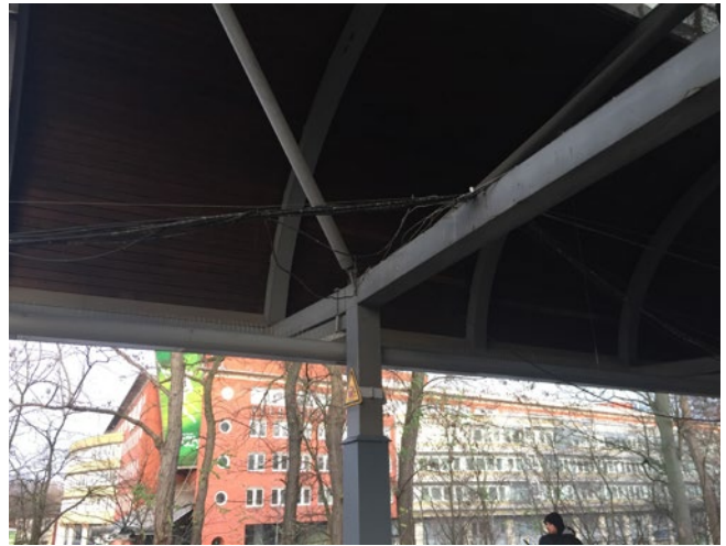
Nach fünf Jahren(!) nach wie vor bestehende provisorische elektrische Leitungen
