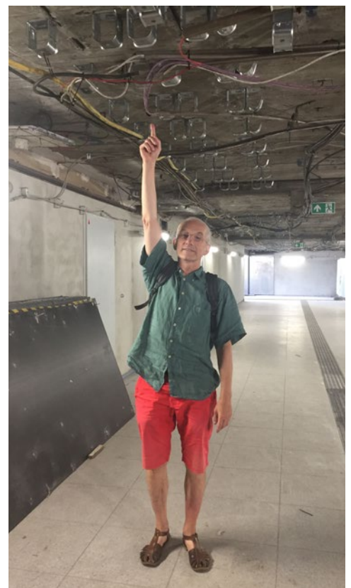
Offene und leicht erreichbare Kabel im U-Bahnbereich
