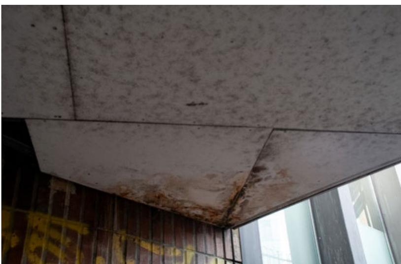
Anscheinend ist die Deckenbekleidung an den Ausgängen nicht für den Einsatzbereich geeignet (z. B. ungeeignete Gipskartonplatten am Übergang zum Außenbereich)
