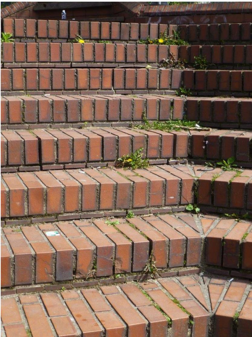
Schadhafte Verfugung im Treppenbereich am Süd Eingang des Bahnhofs
