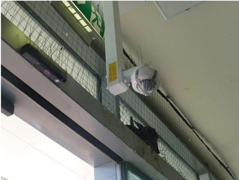
Taubennester zwischen Vergrämungsdornen vor neu installierter Videoüberwachungsanlage
