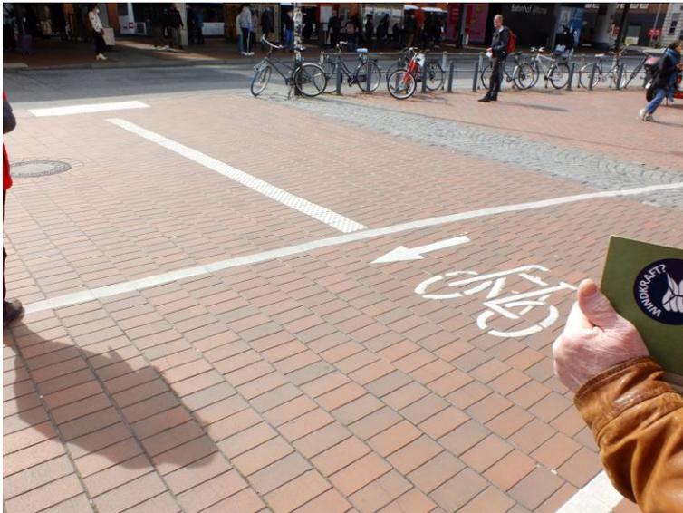
Taktile Leitstreifen endet einfach mal an der Fahrradspur. Insgesamt mangelhaft: Taktile Leitstreifen
