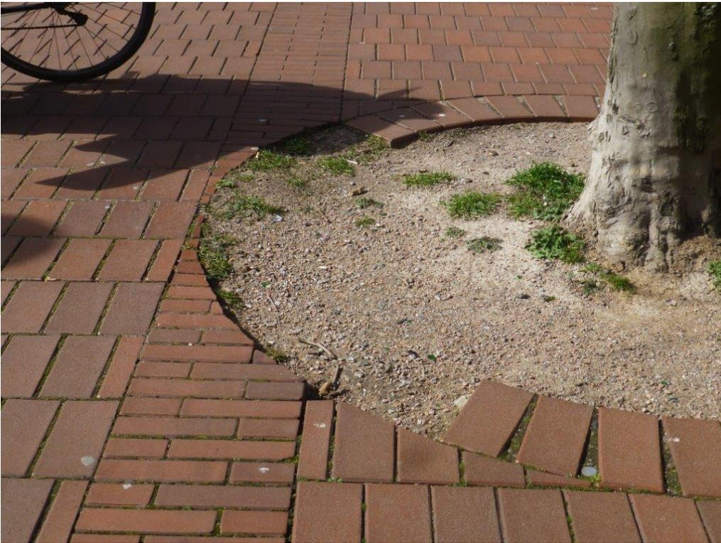
Schadhafte Pflasterung im Bereich der Bäume, zu hohe Bodenverdichtung
