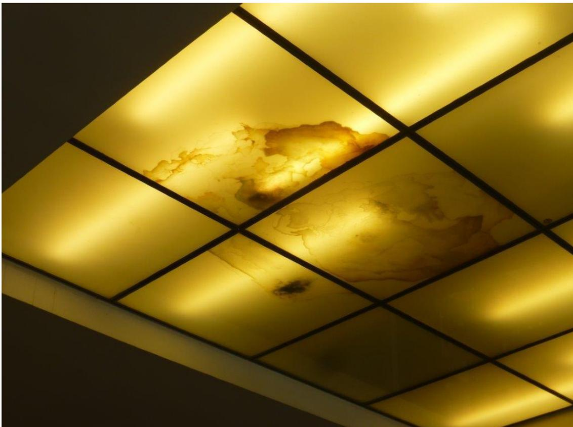
Durch Wasserschäden verdreckte Glasdecken-Leuchten, ca. 50% der Leuchtstoffröhren defekt
