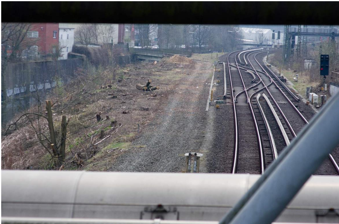
Blick von der Holstenkampbrücke nach Süden
