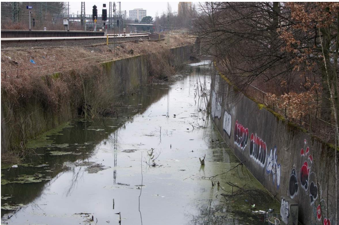
Blick von der Diebsteich-Fußgängerbrücke über den Posttrog nach Norden
