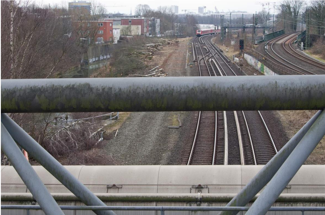
Blick von der Holstenkampbrücke nach Süden
